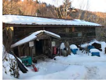
奥多摩小屋外観(2019. 2. 2 営業中)
