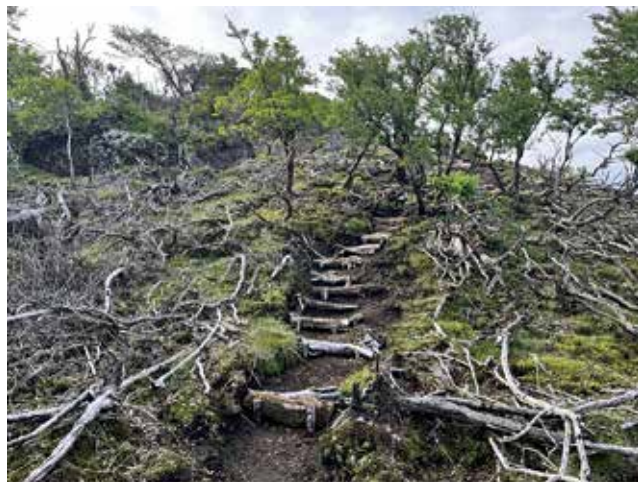
現地の倒木を利用した階段（土留め）
